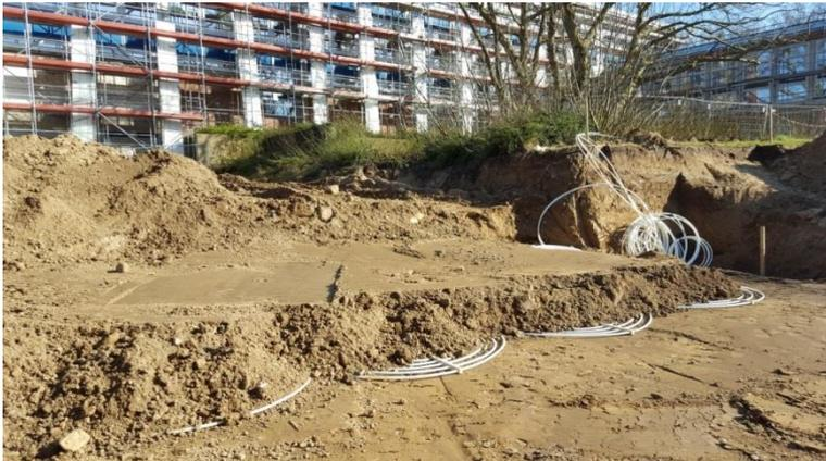
Abbildung 1: Erdkolektor in Sandwichbauweise
