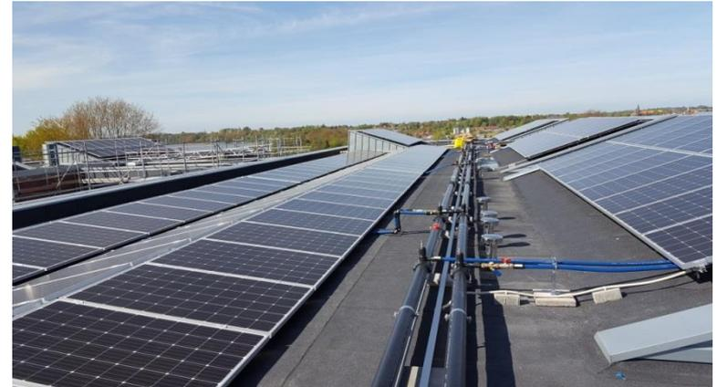
Abbildung 2: Dachabsorber unter PV-Anlage
